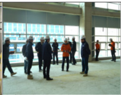
대형 건설 현장 화재취약요인 점검
